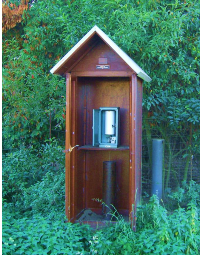
Abb. 13: Grundwassermessstation Wagnitz Quelle: Abt. 14 Wasserwirtschaft, Ressourcen und Nachhaltigkeit
