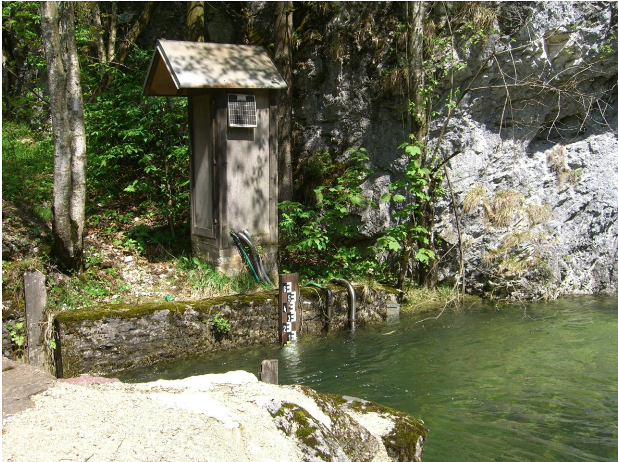
Abb. 13: Quellmessstation Wassermannsloch
