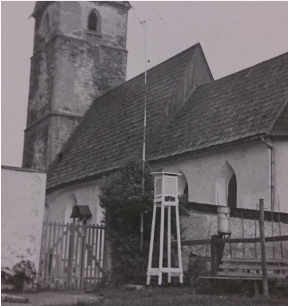
Abb. 13: Niederschlagsstation Wald am Schoberpass im Jahr 1959
