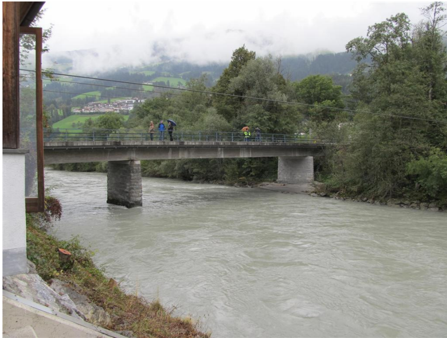
Abbildung 1: Profil Straßenbrücke flussabwärts (Foto: HD Tirol)
