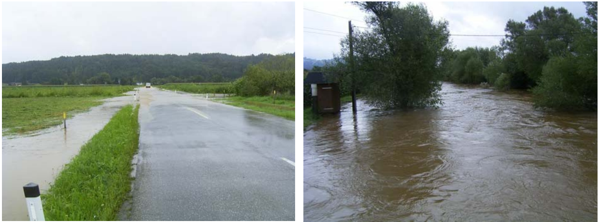
Abbildung 15: links: Umströmung des Pegels Gleinstätten/Sulm; rechts: Hochwasser im Pegelbereich
