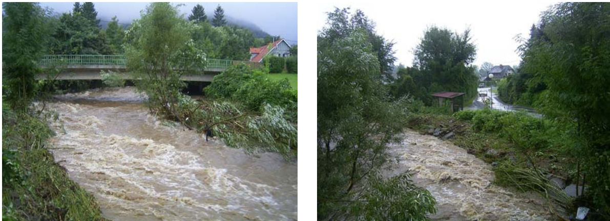
Abbildung 13: Hochwasseranschlaglinien im Bereich Schwanberg
