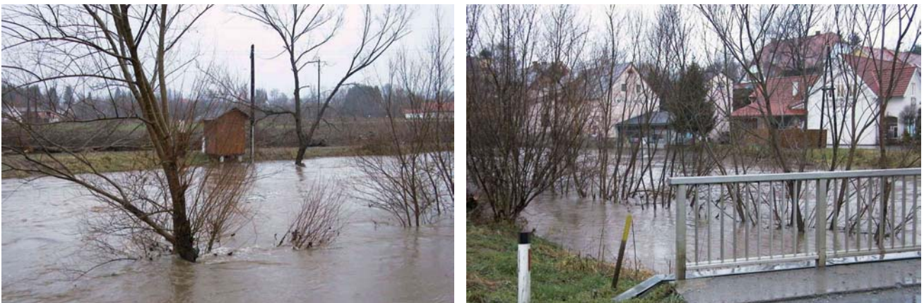
Abbildung 13: Hochwassersituation im Bereich Pegel Gleinstätten/Sulm
