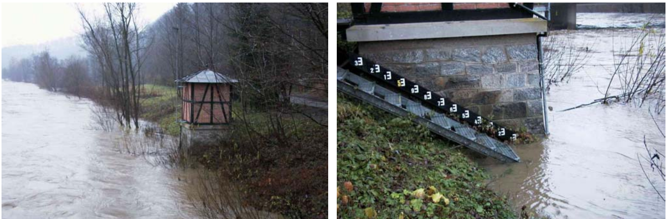
Abbildung 15: Hochwassersituation im Bereich Pegel Leibnitz/Sulm
