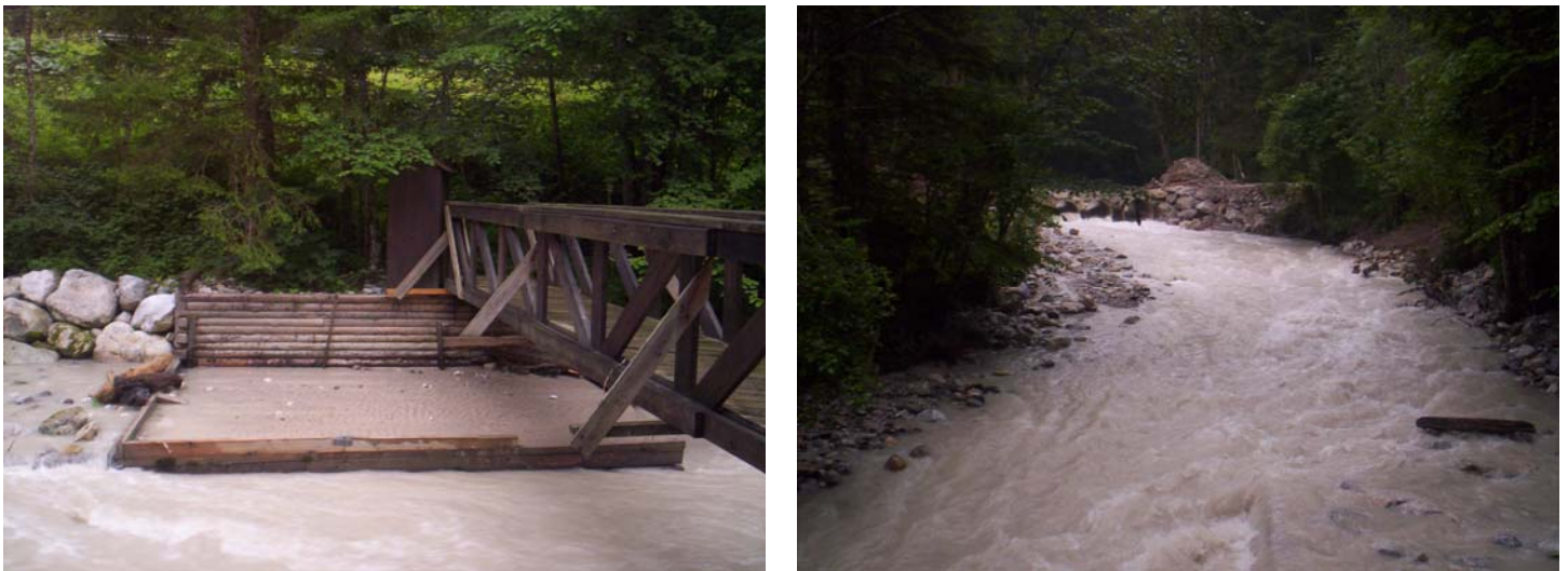
Abbildung 6: links: Pegel Radmer Bahnhof/Radmerbach; rechts: Rohrdurchlass oberwasserseitig des Pegels
