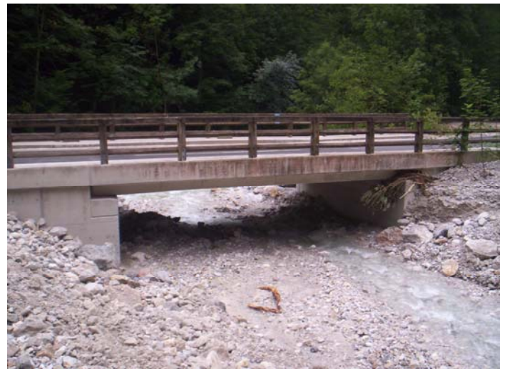
Abbildung 5: Weißenbach im Bereich der Mündung in den Radmerbach mit hohem Geschiebeeintrag
