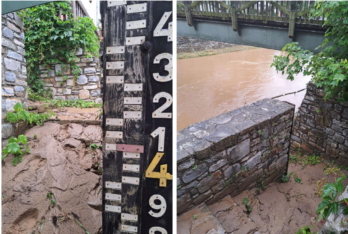
Abbildung 21: Bilder vom Pegelbereich Waltersdorf/Safen vom 10.6.2024
