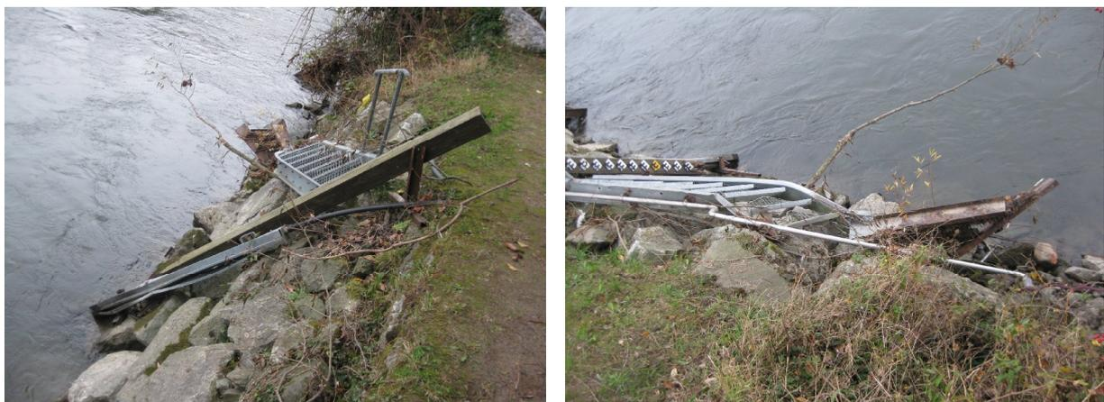
Abbildung 6: Beschädigungen am Pegel Bruck/Mur
