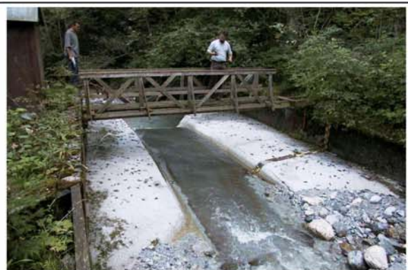
Abb.7: Die Pegelstation MFT
