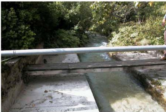
Abb.11: Die Pegelstation MI2
