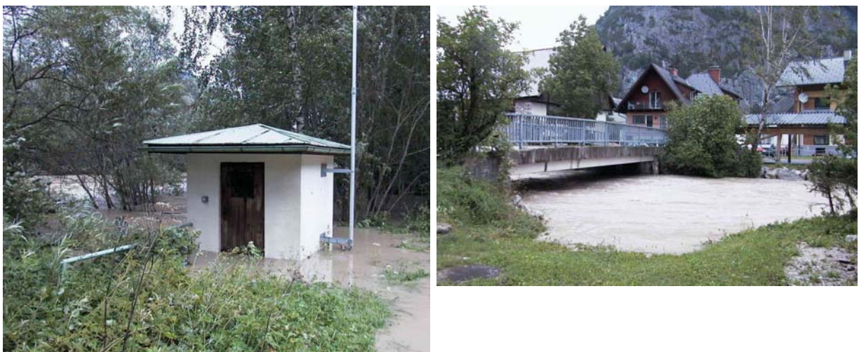
Abb. 10: Pegelhütte Liezen/Enns (links) bzw. Grimmingbach im Pegelbereich (rechts)
