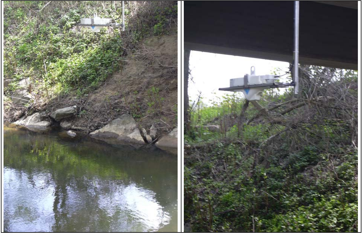
Abbildung 3: FloDar (Fa. Marsh-McBirney) an der Brückenkonstruktion montiert
